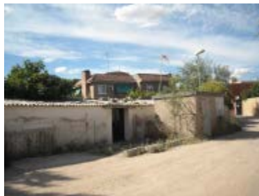
Imagen 61: Viviendas Sector 5. Fuente Informe-diagnóstico sobre la Cañada Real Galiana de FSG y Accem
