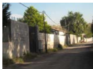
Imagen 60: Viviendas Sector 4. Fuente Informe-diagnóstico sobre la Cañada Real Galiana de FSG y Accem
