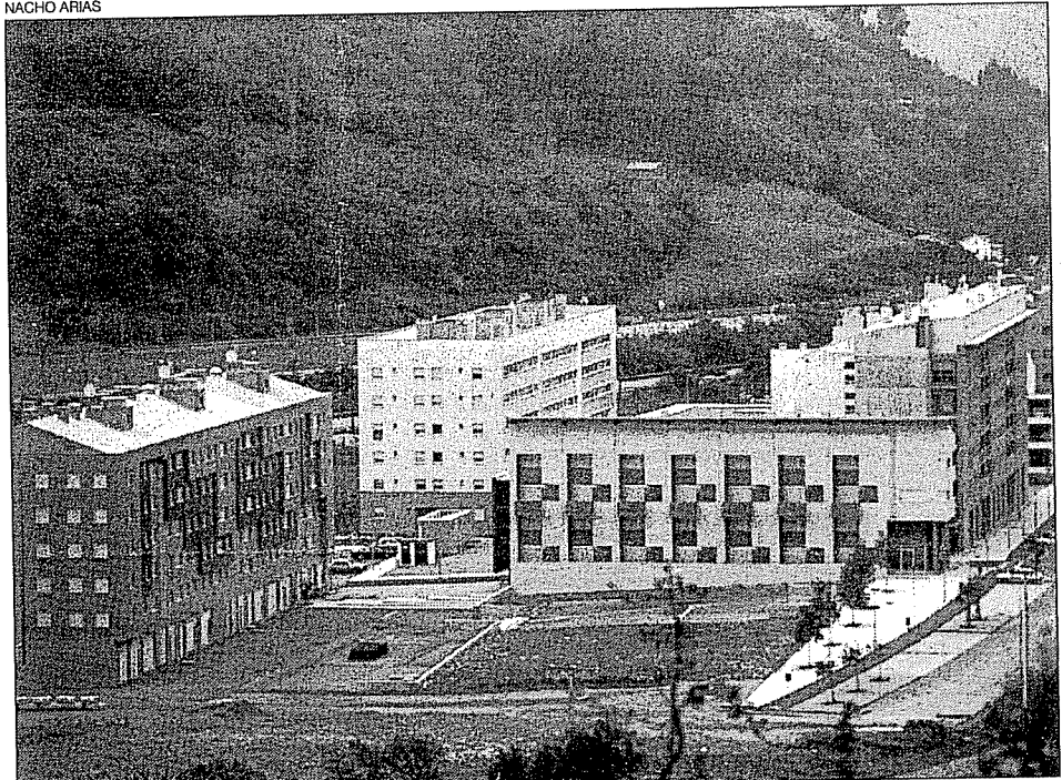
Un bloque de viviendas del Nuevo Santullano, en cuya urbanización residía el matrimonio gitano.
