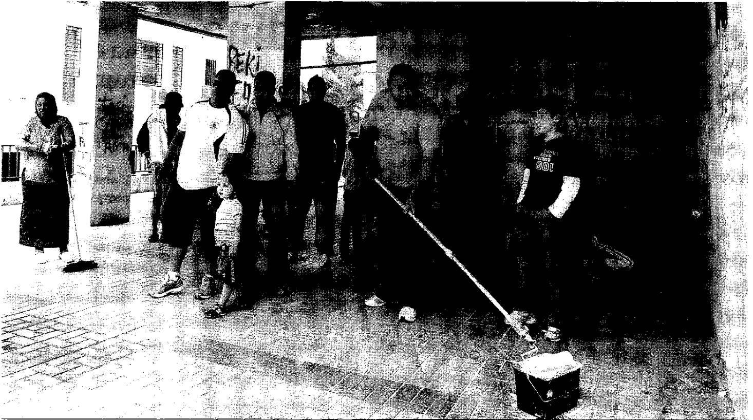
Un vecino de Cabriel 27 se dispone a pintar la fachada del edificio ante la mirada de los demás residentes.
