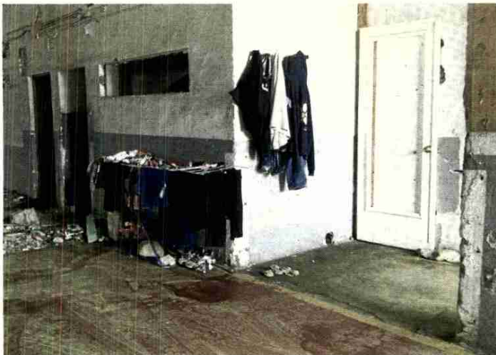
El asentamiento de Arrasate se ubica en una fábrica. REPORTAJE GRÁFICO: ASOCIACIÓN ROMI BIDEAN
