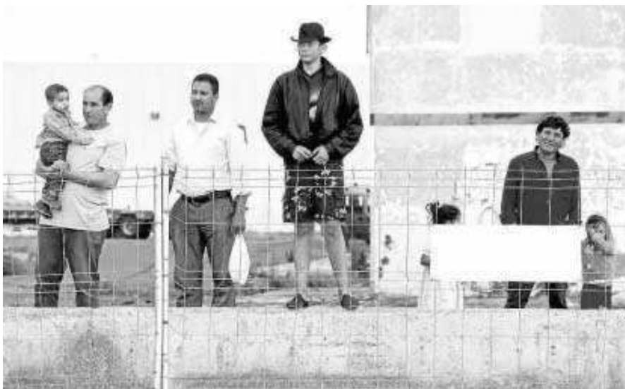
Un grupo de habitantes de El Puche asiste al derribo de viviendas.
